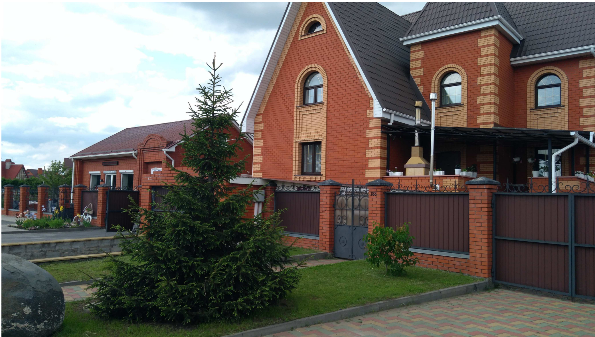
Фотофиксация существующего состояния. Вид со стороны индивидуального жилого дома.
